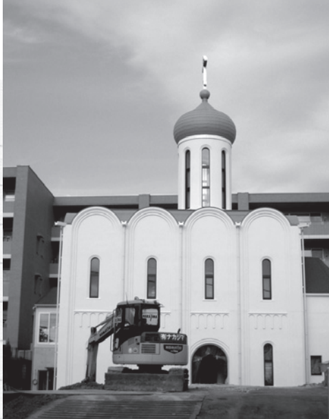
На строительстве нового храма
