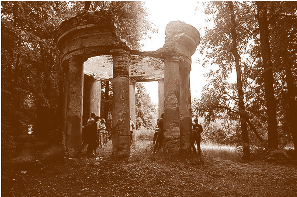
Даже разрушенные усадьбы вдохновили участников экспедиции – мы поняли, что необходимо восстанавливать разрушенное, прежде всего в самих себе
