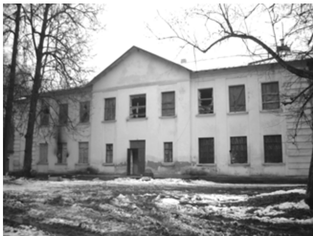
Бывшее здание школы. 2003 г.
